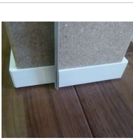
下地の欠き込み部分に はめ込むように取付け
