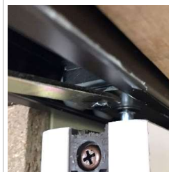
②同梱のスパナで可動子の固定ネジの締付けを調整
