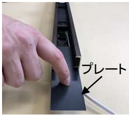
戸先側より プレートを抜く
