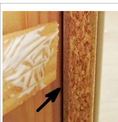
柱面からクサビ等が飛び出している
