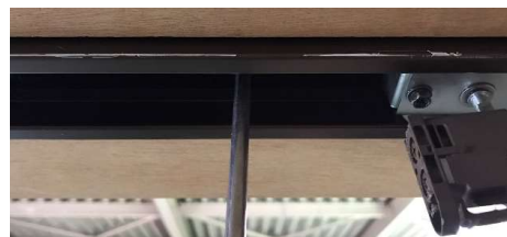
①手動ドライバーでビスを半回転程緩める
