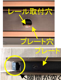
プレートをプレート穴とレール取付穴の 位置を合わせて元通りに差し込む ※プレートは奥まで差込と戸先側に隙間が空きます
