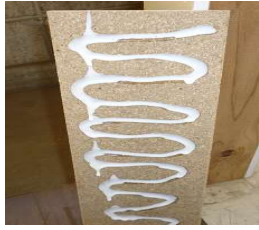
下地裏面に接着剤全面塗布
