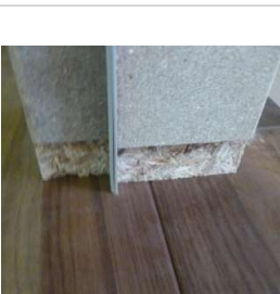
下地の幅木欠き込み部分 (7×30)
