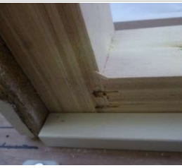
見切縁の取付け
