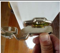
クリップ部分を座金の突起部分に押し当てる
