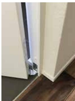
枠を壁厚内の大きさまでコンパクトにし目立たず、それでいて枠の機能をしっかりと持っているインセット枠。調整機能がついているので、枠の取付時や経年変化時のメンテナンスの際に簡単に建て付け調整が可能です。
