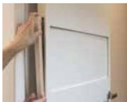
取手部が飛び出したら、そのまま抜き取ります。
