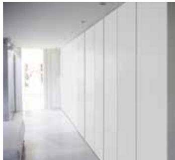
出入り口ドアだけでなく、クローゼットも壁面化®を追求。枠がないので扉と壁がフラットになるスマートな納まりです。
