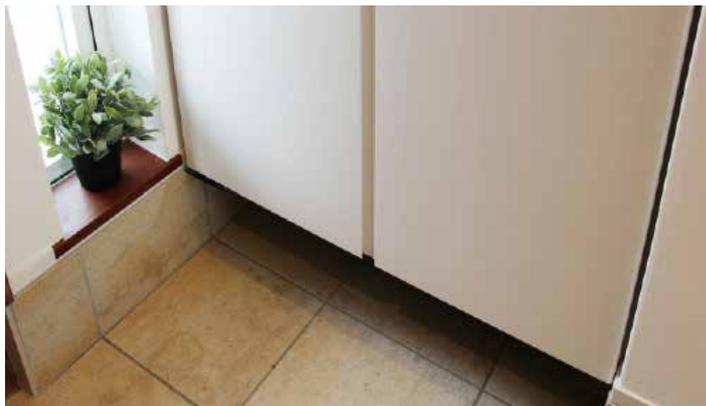
玄関の土間の様な床面に設置できない場所に浮かせて取り付けができる
