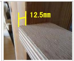
② 上枠下地と石膏ボードを連続して納める場合、野縁を躯体にしっかりと固定します。その際、石膏ボードの厚さを確保してしてください。その後、石膏ボードを上枠下地に合わせて野縁に固定してください。
