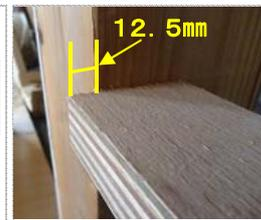
② 上枠下地と石膏ボードを連続して納める場合、野縁を躯体にしっかりと固定します。その際、石膏ボードの厚さを確保してください。その後、石膏ボードを上枠下地に合わせて野縁に固定してください。
