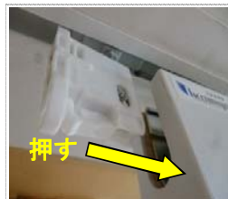
固定カップと 上部吊車を連結する
