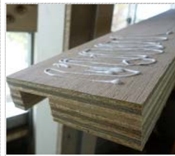
下地裏面に接着剤全面塗布
