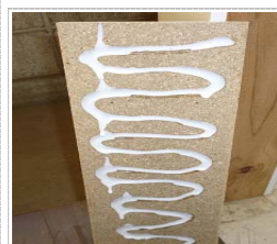
下地裏面に接着剤全面塗布
