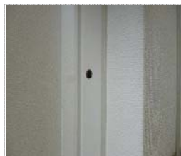
インセット枠固定 (MSビス)
