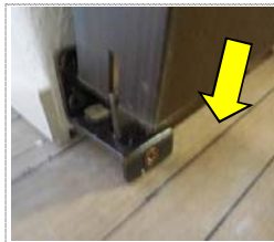
壁付ガイドに 建具溝を差し込む
