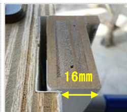
飛び出した状態 (見付16mm)
