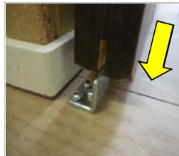
床付ガイドを 建具溝に差し込む
