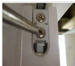
上部吊車 上下の調整
