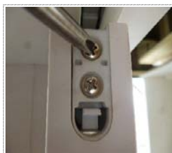
上部吊車 前後の調整
