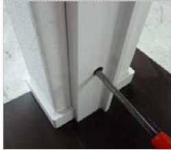
手動ドライバーで完全に固定
