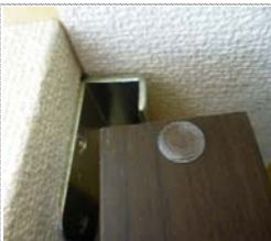
ガイドピースに建具上部木口のガイド溝から 建具を差し込む
