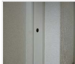
インセット枠固定 (MSビス)
