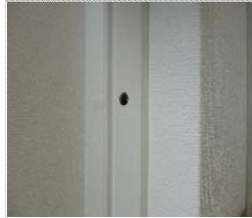
インセット枠固定 (MSビス)
