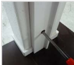
手動ドライバーで完全に固定
