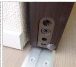
建具下部の戸車を床付レールの溝に乗せる。 ガイド溝に完全にかかる。
