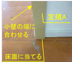
定規を床仕上面にあてる 小壁の端に合わせる
