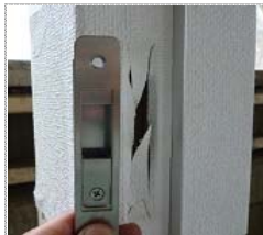
金物加工部分をカッターで切り込み
