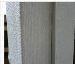
金物加工部分も クロスを巻き込む
