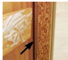
クサビまたはパッキンの表裏に接着剤を塗布し、縦枠下地と躯体の間に差込む
