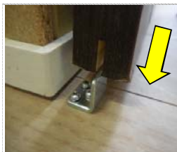
床付ガイドを建具溝に 差し込む
