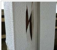
金物加工部分をカッターで切り込み
