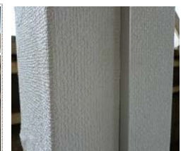
金物加工部分も クロスを巻き込む
