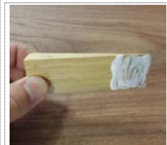
クサビまたはパッキンの表裏に接着剤を塗布し、縦枠下地と躯体の間に差込む
