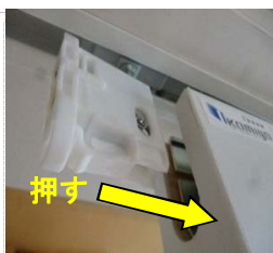
固定カップと 上部吊車を連結する
