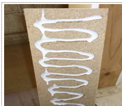
下地裏面に接着剤全面塗布
