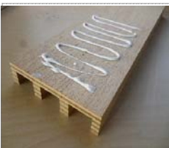
下地裏面に接着剤全面塗布
