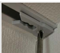
最後の締め付けは 手動ドライバーで行う
