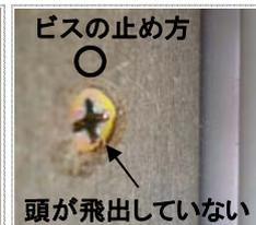
調整ビスにより枠を固定
