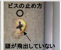
調整ビスにより枠を固定
