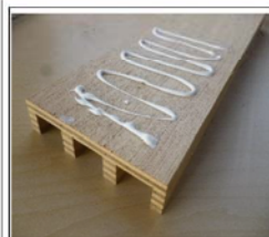
下地裏面に接着剤全面塗布
