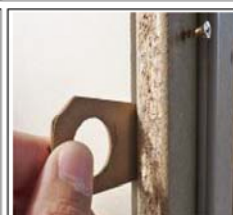
2mmのクリアランスを保ち調整、ビスにより枠固定
