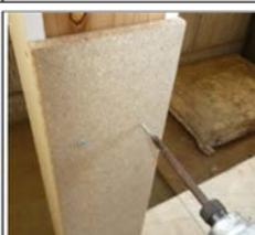
下地表よりビス固定                              |
