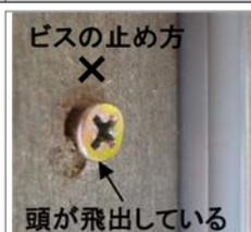
ビスの止め方 × 頭が飛出している                    |
