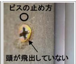
調整ビスにより枠を固定
