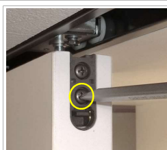
建具溝を床付けガイドに 差し込み、建具を起こす
