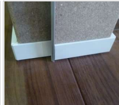
下地の欠き込み部分にはめ込むように取り付け
