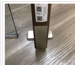
上側カバーをビスで取付け
