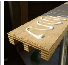
下地裏面に接着剤全面塗布
