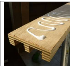
下地裏面に接着剤全面塗布
