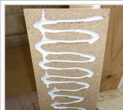
下地裏面に接着剤全面塗布
