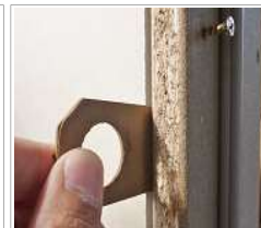
【準耐火納まりの場合】 コーススレットビスで固定(2mmクリアランスは無)入隅の場合、石膏ボードの上に縦枠を取付け
