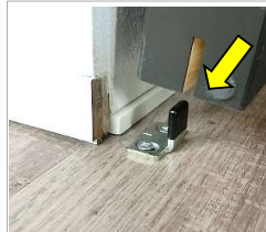
建具溝を 床付ガイドに差し込む
