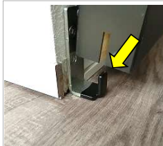
建具溝を 壁付ガイドに差し込む
