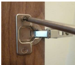
手動ドライバーで完全に固定
