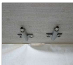
ソフトクローズキャッチの取り付け
