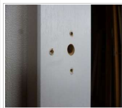
枠の座金用の下穴加工
