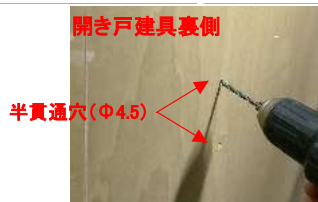
建具裏面の半貫通穴 (Φ4.5) をドリルで貫通させる
