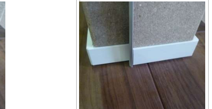
【塗り壁仕上の場合】 切欠寸法：4×30
