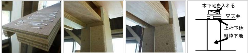
下地裏面に接着剤全面塗布 縦枠勝ちに納める 下地表よりビス固定 上枠下地の裏には木下地を入れる
