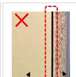
石膏ボード 下地枠
