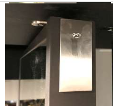
上側カバーをビスで取付け
