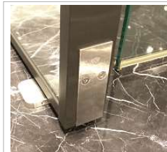
下側カバーを付属のビスで取付け ※強く締め過ぎないように注意
