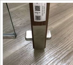
上側カバーをビスで取付け
