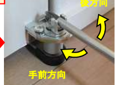
左右の調整(上下部のヒンジ)
