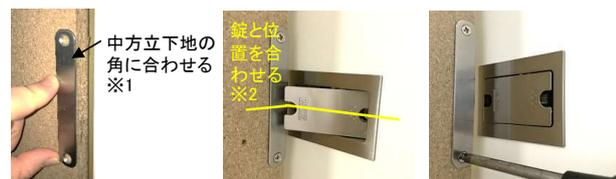
塗り壁の場合は、受け金物を中方立下地の端部から3mm出し、所定の取り付け高さ位置に合わせ、付属ねじで固定します。
