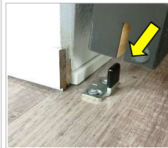
建具溝に 床付ガイドを差し込む
