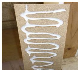
縦枠下地裏面に接着剤全面塗布(推奨：酢ビ系)
