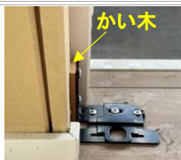
【標準(12.5mmボード)の場合】 厚み5.5～7mm×巾22mm×高さ61mmのかい木を当て壁付用下部固定金具を取付
