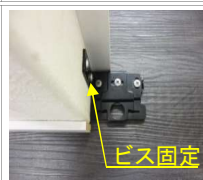
【準耐火(15mmボード)の場合】 壁付用下部固定金具の取付け ※幅木は廻さずかい木も使用しない
