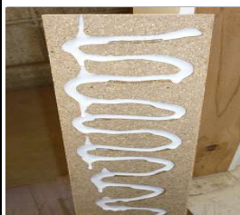
中方立下地裏面に接着剤 全面塗布(推奨：酢ビ系)
