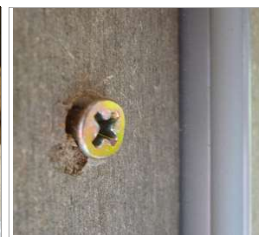
調整ビス頭の飛び出し ×
