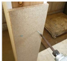
小壁を立てて 中方立下地を取付
