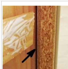
クサビ又はパッキンに接着剤を塗布し縦枠下地と柱をガッチリ固定(クロス・塗り壁のヒビ割れ防止策)
