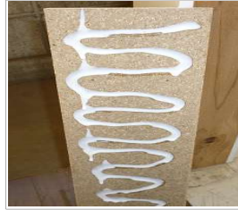
下地裏面に接着剤全面塗布
