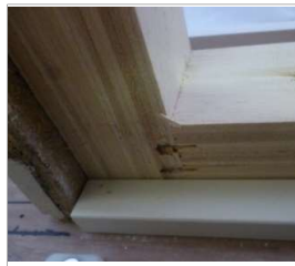
見切縁の取付け
