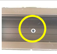
戸尻側 Ⓘ Ⓕ プレートが無くビス穴のみ
