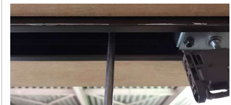
①手動ドライバーでビスを半回転程緩める
