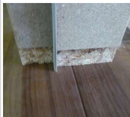
下地の幅木欠き込み部分 (7×30)
