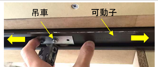
Ⓖ : Ⓕ のビス穴2箇所は、緑色のテープを剥がし可動子を左右端へ移動させて出現させます
