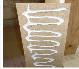
下地裏面に接着剤全面塗布
