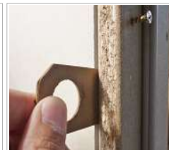
【準耐火納まりの場合】 コーススレットビスで固定(2mmクリアランスは無)入隅の場合、石膏ボードの上に縦枠を取付け
