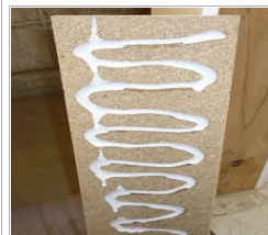
下地裏面に接着剤全面塗布
