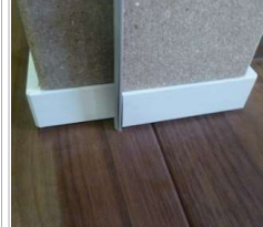
下地の欠き込み部分にはめ込む様 に取付け
