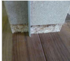
下地の幅木欠き込み部分 (7×30)
