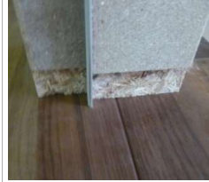
下地の幅木欠き込み部分 (7×30)
