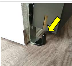
建具溝を 壁付ガイドに差し込む
