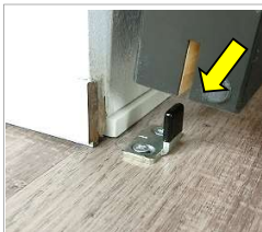
建具溝を 床付ガイドに差し込む
