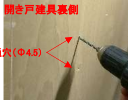
建具裏面の半貫通穴（Φ4.5）をドリルで貫通させる
