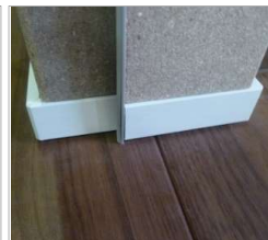
下地の欠き込み部分に はめ込む様にと付け
