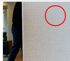
枠に巻き込む際、クロスは上下左右余裕 もったサイズでまっすぐ貼る
