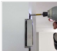
同梱ビス(4.5×30)でヒンジを取付ける
