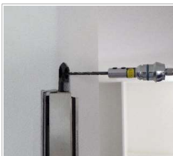
クロスを巻き込みヒンジをはめ、下穴φ3を空ける
