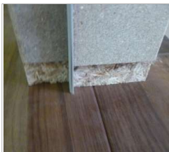
下地の幅木欠き込み部分 (7×30)
