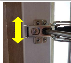
上下方向の調整 4ヶ所全ての丁番のビスを緩め 上下にスライドさせる
