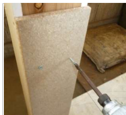
小壁を立てて 中方立下地を取付
