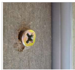
調整ビス頭の飛び出し ×
