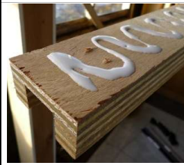
下地裏面に接着剤全面塗布
