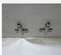
建具裏面の半貫通穴（Φ4.5）をドリルで貫通させる
