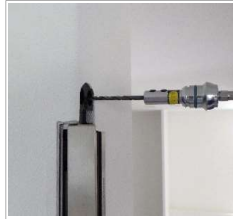
クロスを巻き込みヒンジをはめ、下穴φ3を空ける
