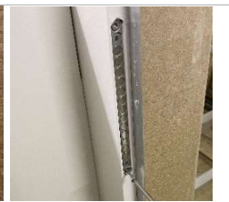
同梱のヘキサロピュラレンチT20を使い、 同梱ビス(*4.5×40)で取付ける
