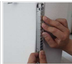
クロスを巻き込み、金物 をはめ下穴φ3を空ける
