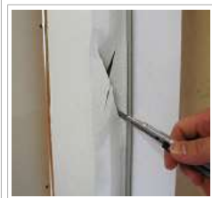
金物加工部分を カッターで切り込み
