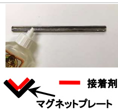
マグネットプレートの内側2面に接着剤を塗る
