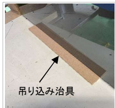
吊り込み用治具を引きガラスを乗せる
