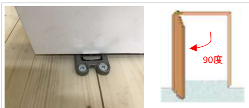
90度開いた状態で、下部フロアヒンジ受けに扉側の下部ヒンジの軸を入れる
