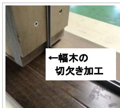
縦枠下端の幅木切欠き加工部 深さ4mm(塗り壁の場合)
