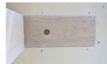
吊元側天井見上げ写真
