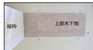
吊元側天井見上げ写真
