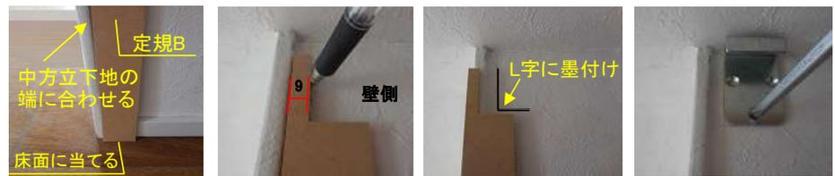
アウトセット片引き戸(床付レール)の場合、床付レールの見込み方向の真ん中に端部から2.5mm離し、下部戸当りの座を固定し、ゴム製カバーを取付けてください。
