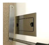
塗り壁の場合は、受け金物を中方立下地の端部から3mm出し、所定の取り付け高さ位置に合わせ、付属ねじで固定します。
