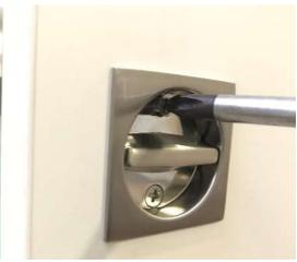
扉にアウトセット引戸錠を取り付けた後、受け金物を中方立下地の角部と扉に取り付けたアウトセット引戸錠の高さ位置に合わせ、付属ねじで固定します。
