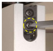
下側のネジで 上下調整
