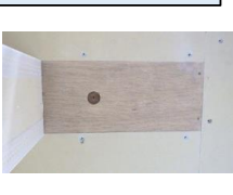
吊元側天井見上げ写真
