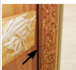
クサビ又はパッキンに接着剤を塗布し縦枠下地と柱を ガッチリ固定(クロス・塗り壁のヒビ割れ防止策)
