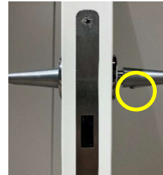
扉戸先木口面から見て右側のハンドルの六角ネジを締める
