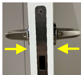
両側から押し付けながら手動+ドライバーでネジ締め
