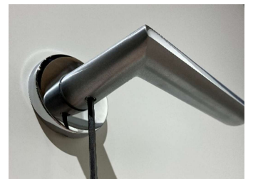
φ3六角レンチでネジ締め
