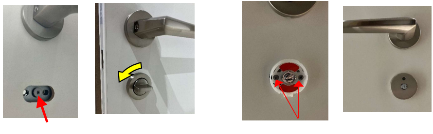
芯棒がついている側の六角ネジは外さない 両側から押し付けながら手動+ドライバーでネジ締め
