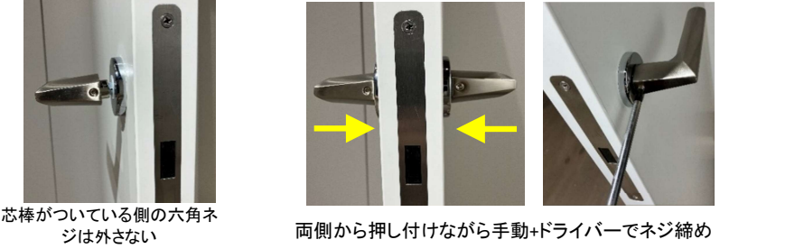
座の軸がある方を扉に挿し仕込む 反対側の座を同梱のビスで止める カチッと鳴らないハンドル例 (JF・JG) カバーを取付ける
