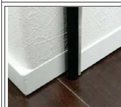
タイト材を床面に合わせてカットする
