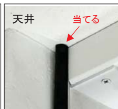
タイト材を図の向きで、上端は天井に当て、長手方向は樹脂見切り端部（赤丸部）に合わせ、貼り付ける
