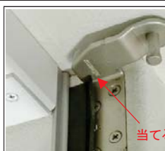
タイト材を図の向きで、上端は上ヒンジ受金物に当て、長手方向は樹脂見切りに当て、縦枠（クロス面）に貼り付ける
