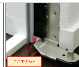
タイト材を下ヒンジ受金物に合わせてカットする
