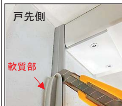
戸先側樹脂見切りの軟質部を切落す
